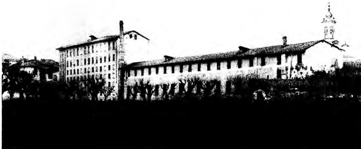
Sede di via S. Lazzaro vista da via Palma il Vecchio.
